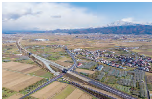
東北中央自動車道
