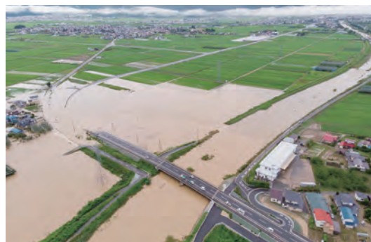
令和2年7月豪雨による白水川堤防決壊
