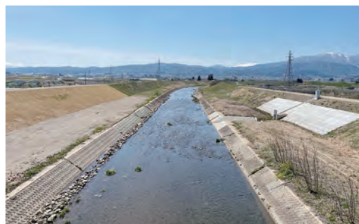
白水川築堤工事
